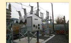
電気設備の更新
