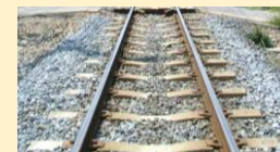
マクラギのコンクリート化
