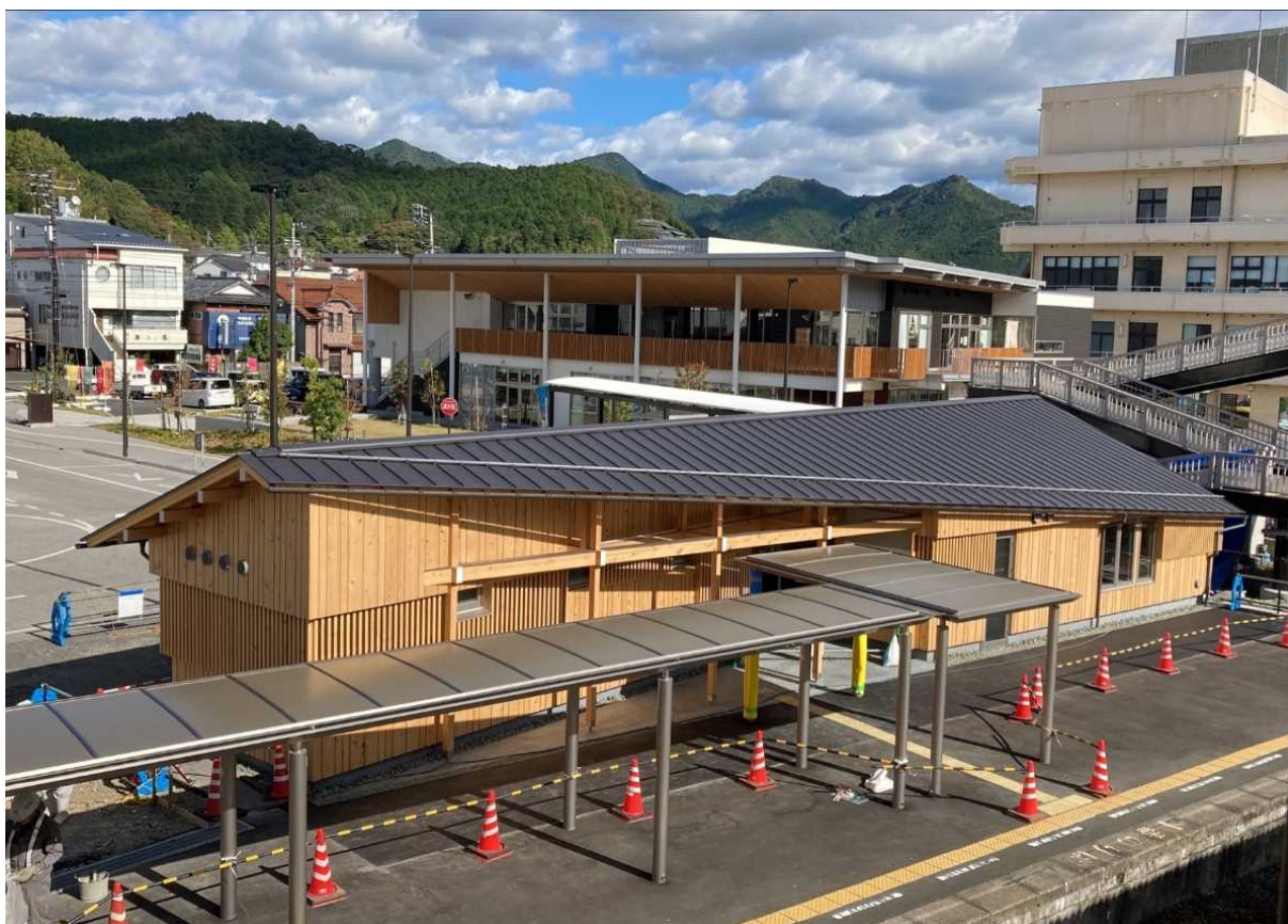
新駅舎整備状況（ホーム側）
